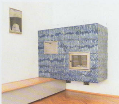
Kachelgrundofen in Zusammenarbeit mit dem Designer Christian Steiner. Der Durchbauofen mit 4 kW Leistung wiegt etwa 1.800 kg und wurde, um den schönen Parkettboden unversehrt zu lassen, an die Wand „gehängt“. Die selbst hergestellten Keramikplatten wurden mit einem Stein bearbeitet um diese Oberflächenstruktur zu erreichen. Foto: C. Steiner, steinerdesign
